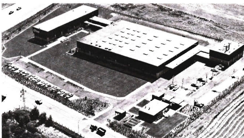
Das GLAXO-Werk, Luftaufnahme, freigegeben unter Nr. 2148/73 LA
