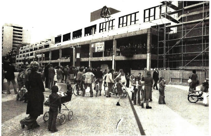
Richtfest für die Praxisklinik Mümmelmannsberg. Die gemeinschaftlichen Behandlungsräume werden im Untergeschoß untergebracht, im Erdgeschoß das Gemeinschaftslabor und einige Praxen, im ersten Stock weitere Praxen, im zweiten und dritten Stock die Bettenstation sowie die beiden Operationstrakte. Foto: C/K
