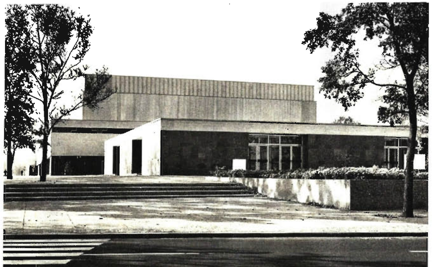
Beratungsort des 82. Deutschen Ärztetages vom 15. bis zum 19. Mai in Nürnberg: die Meistersingerhalle Foto: Bauamt für Hochbauwesen, Nürnberg
