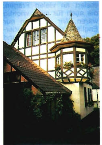
Im südlichen Bad Godesberg steht dieses Rheinische Fachwerkhaus Foto: gb
