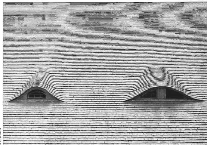
Schindeldach auf dem Bootshaus des Yachtclubs in Starnberg
